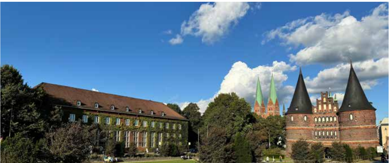
Das Gebäude der ehemaligen Bundesbank am prominenten Standort neben dem Holstentor
