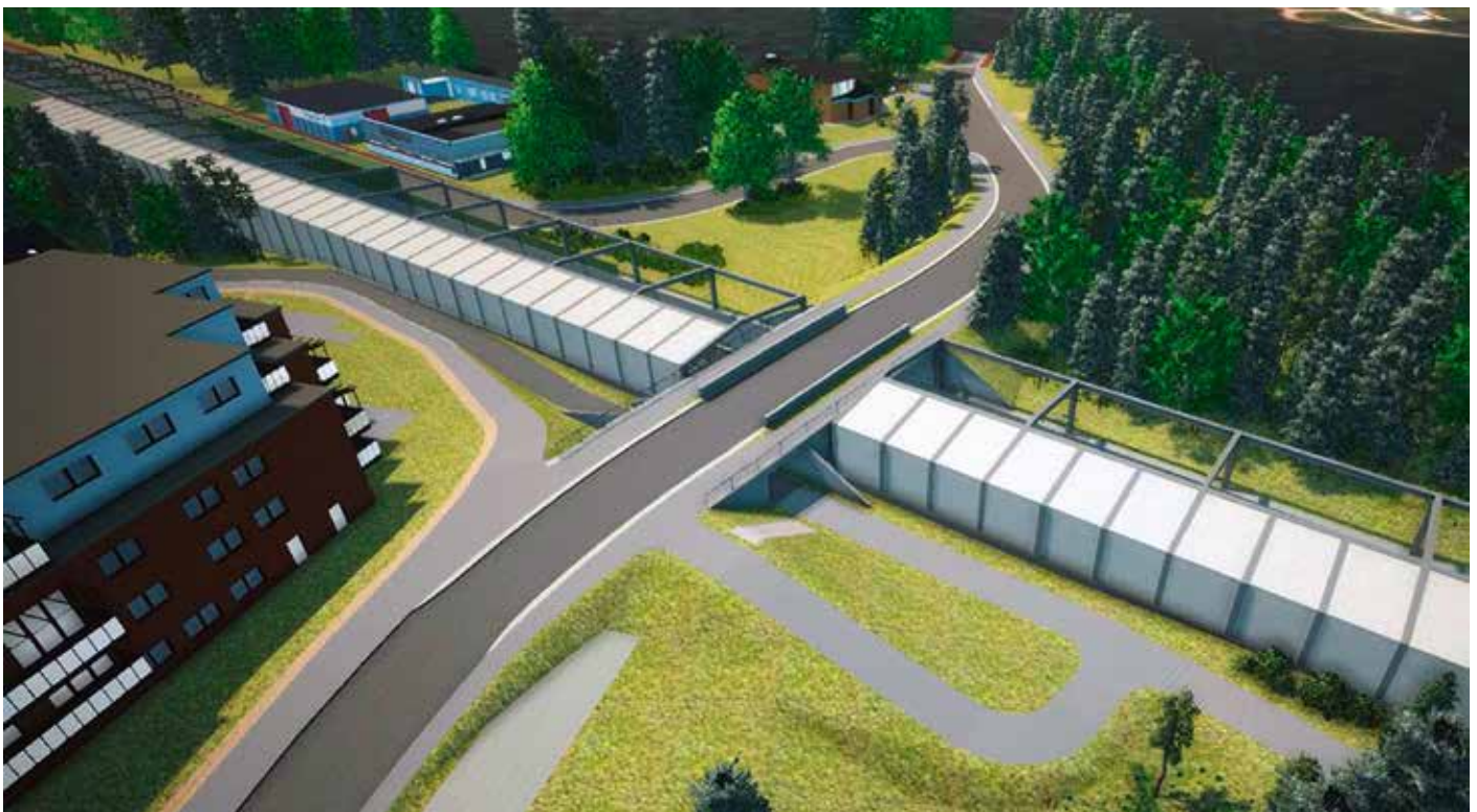
Die Straßenbrücke an der Kaltenhöfer Straße. In Zukunft soll es hier keine Schranken mehr geben.
