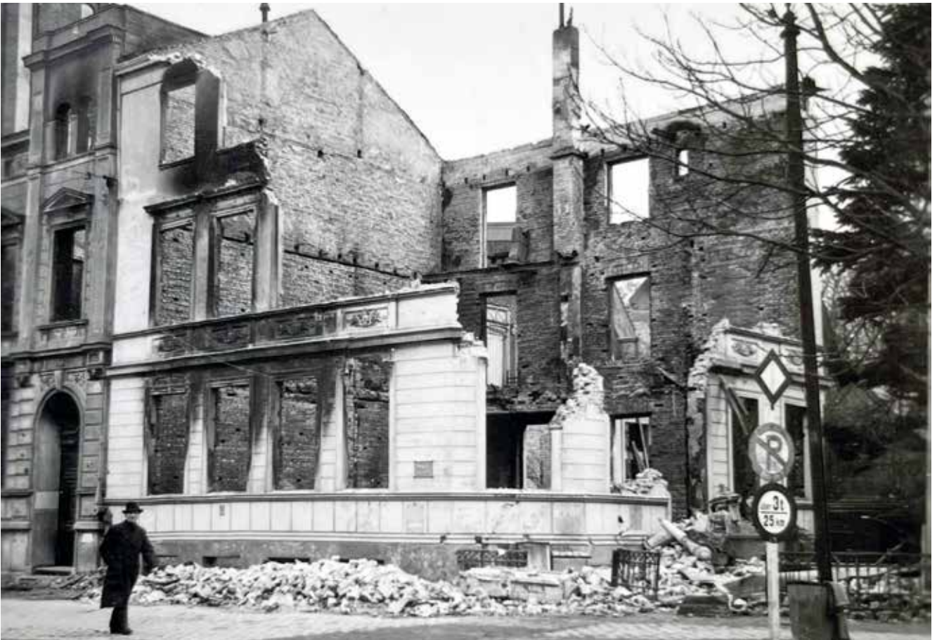
Ruine des Hauses Mühlenstraße 17, 1942
